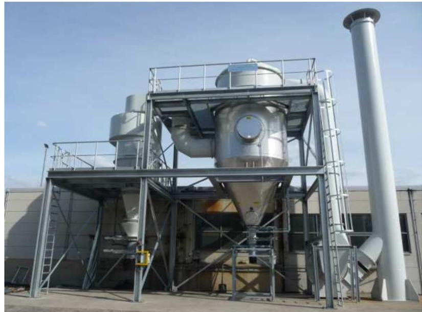
Abb. 4: Abluftreinigungsanlage nach ATEX
